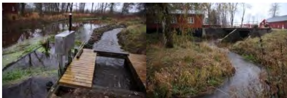
Figur 5: Indløb til omløbet (tv), omløbet inden udløb nedstrøms opstemningen (th).
