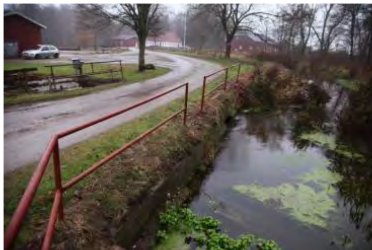
Figur 12: Overkørsel for Vandmøllevej ved dambrugets vandindtag.
