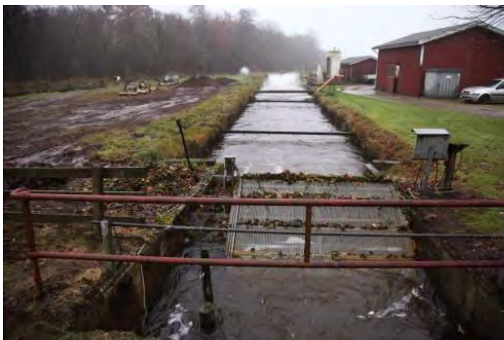
Figur 18: Føddekanal til dambruget med 10 mm rist.
