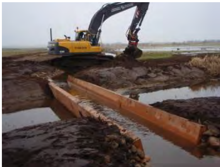
Figur 28: Praktisk eksempel på aquadukt.
