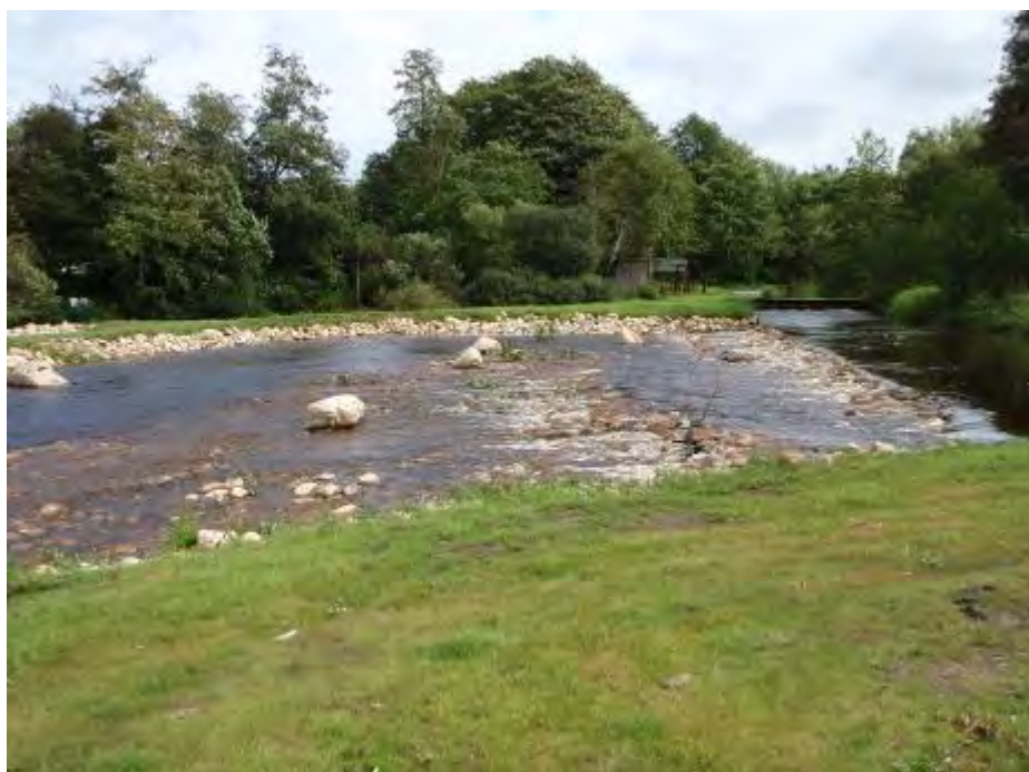
Figur 31: Eksempel på banket nedstrøms en flodemåls spuns (ses til højre billedet) og med udskæring i begge ender af spunsen til en strømmende (foto fra rådgiver, Per Søby Jensen).
